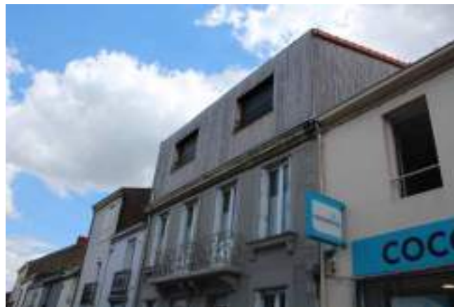
Surélévation du bâti dans le centre-bourg de Vallet
