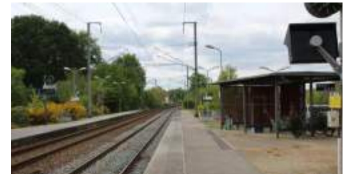
Gare de la Haie-Fouassière (atopia)
