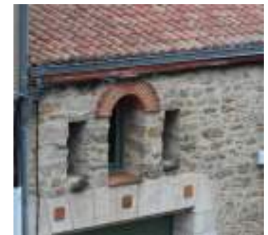
Encadrement de brique et moellon apparent, atopia
