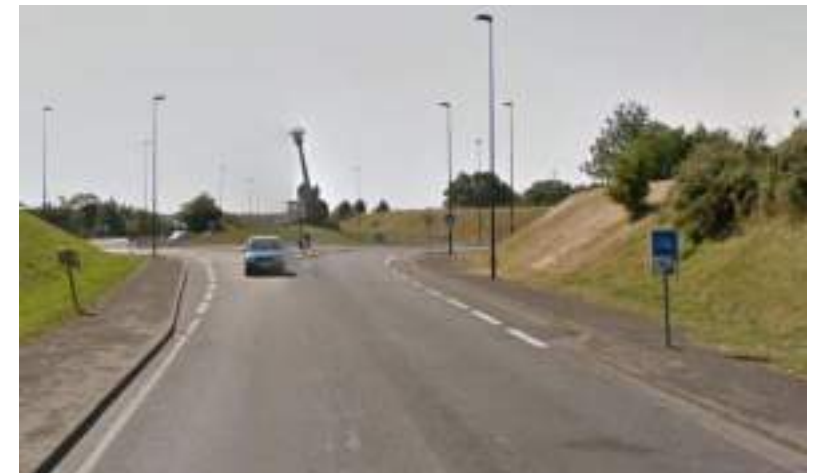
Aménagement cyclable d'un giratoire à proximité de Clisson(Google maps)
