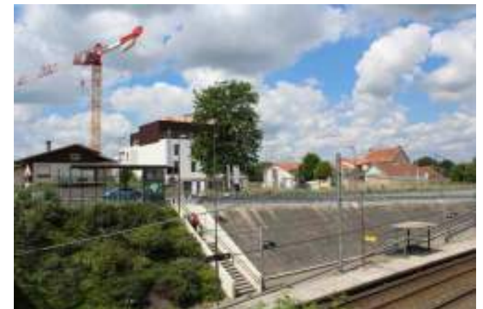
Gare de Gorges et nouveau bâtiment (atopia)
